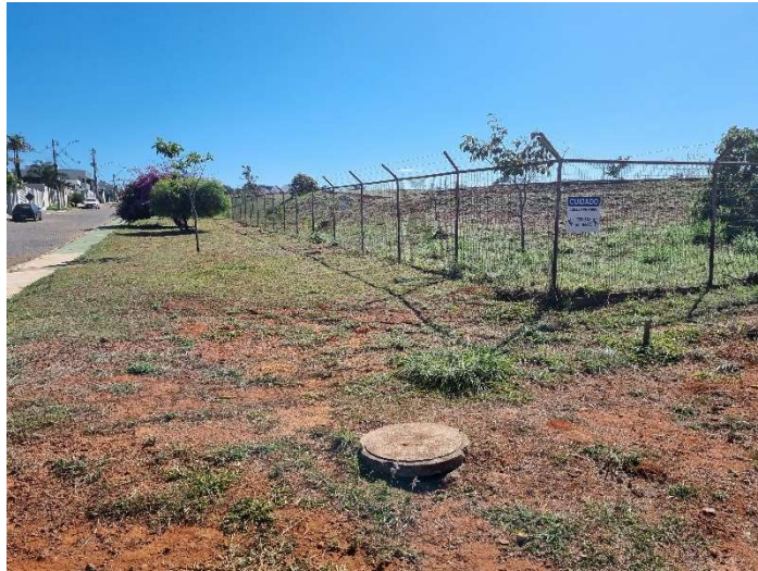
Bacia de águas pluviais da quadra 104
