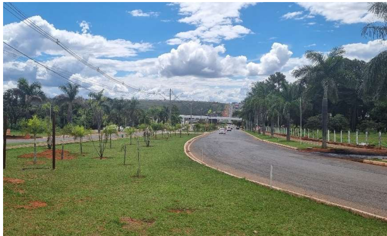
Acesso da BR 020 à portaria
