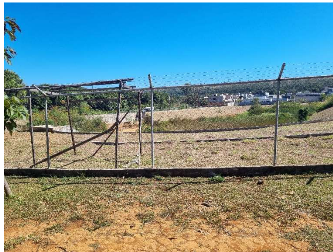
Bacia de águas pluviais da quadra 202
